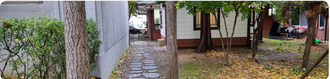
휴게시설 주변 조경석 설치
